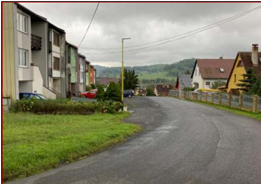
Obrázek 4 Stávající stav komunikací – chybějící chodník
