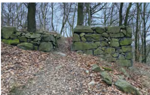
Základy hostince Netterskoppe nedaleko Lesné.
